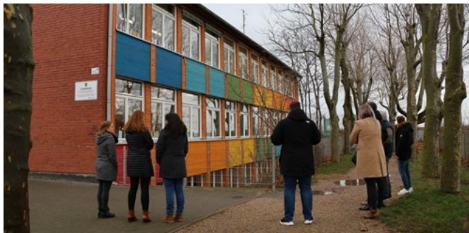
Farbenfrohe und energetisch modernisierte rückwärtige Fassade an der KGS Huchem-Stammeln
