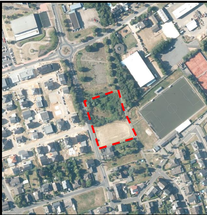
Abb. Luftbild Bestand – die Fläche im Norden wird aktuell bereits wieder bebaut – die Bebauung im westen ist fortgeschritten. – Plangebiet (rot)- keine Erweiterung des Untersuchungsraumes
