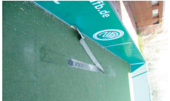
Zerstörter Bodenbelag des Minispielfeldes in Huchem-Stammeln
